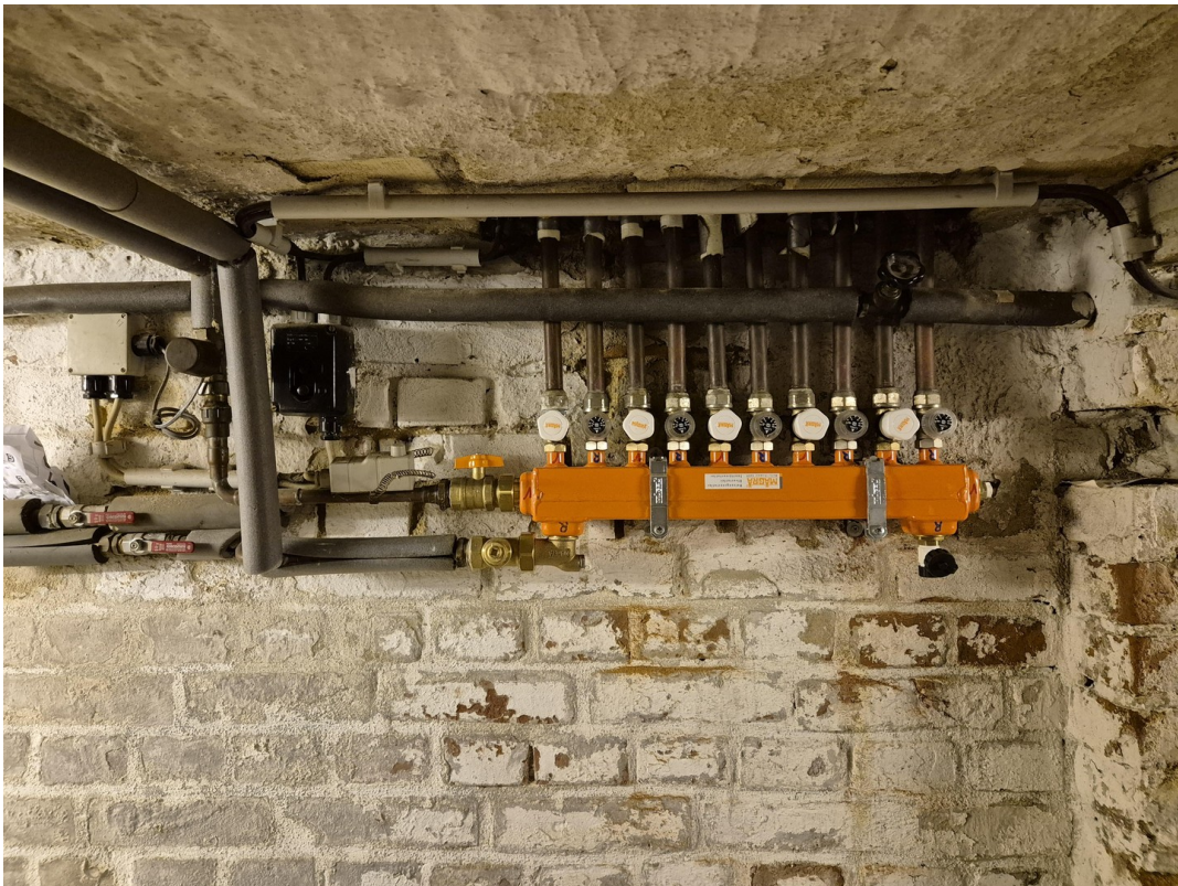
Heizkreisverteiler Bj2024
