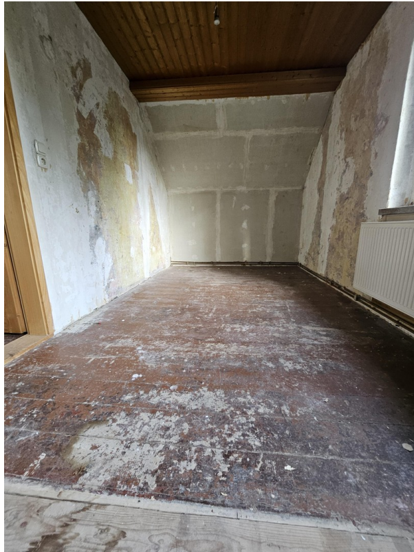
1.OG großzügiges Kinderzimmer
