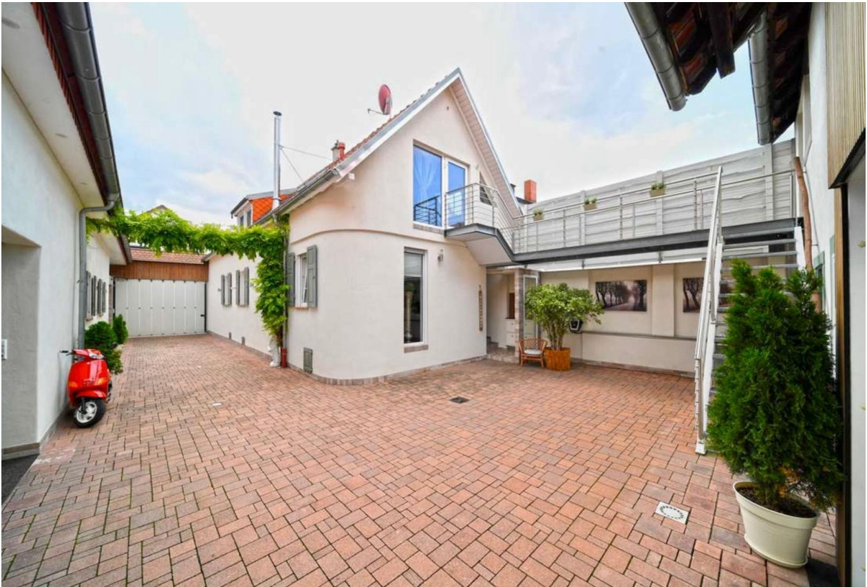
Hof mit Blick auf Eingangstor
