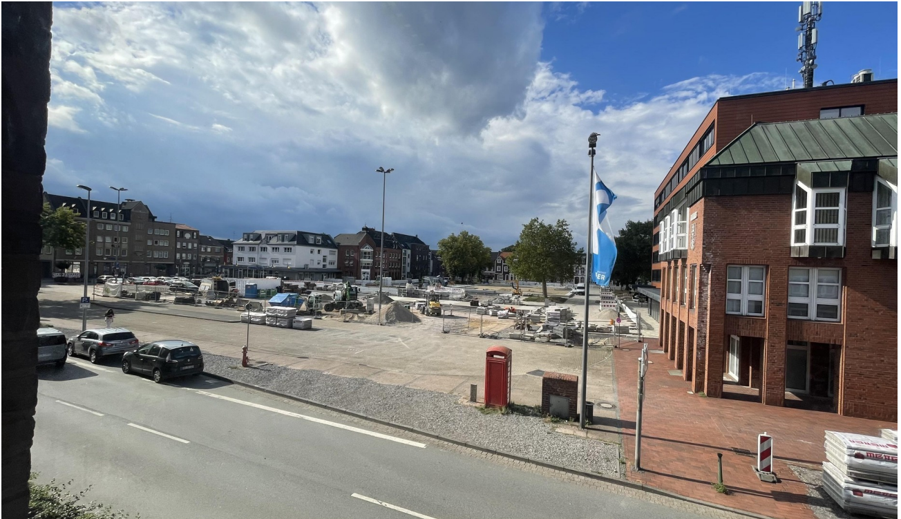
Büro Raum 3, Blick zum Markt
