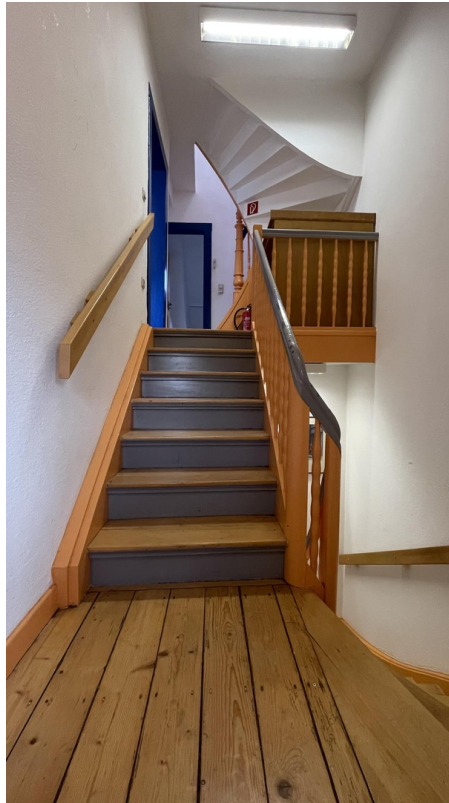
Treppenhaus 1. zur 2. Etage
