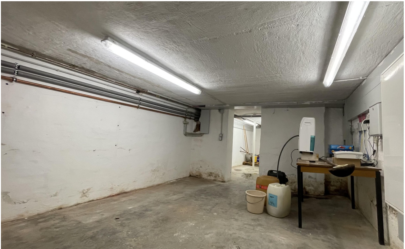
Keller Lagerraum 180 cm Höhe
