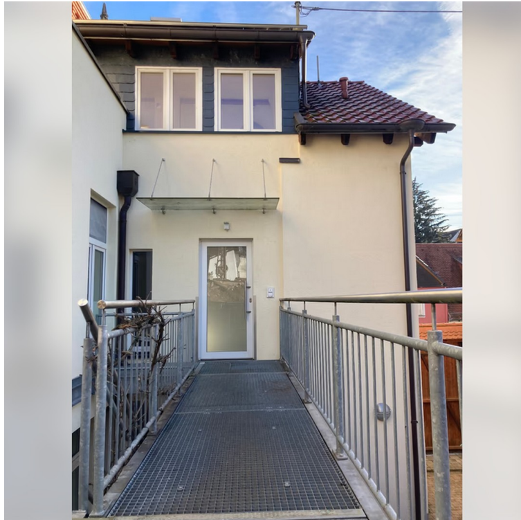
Obere Wohnung, Eingang
