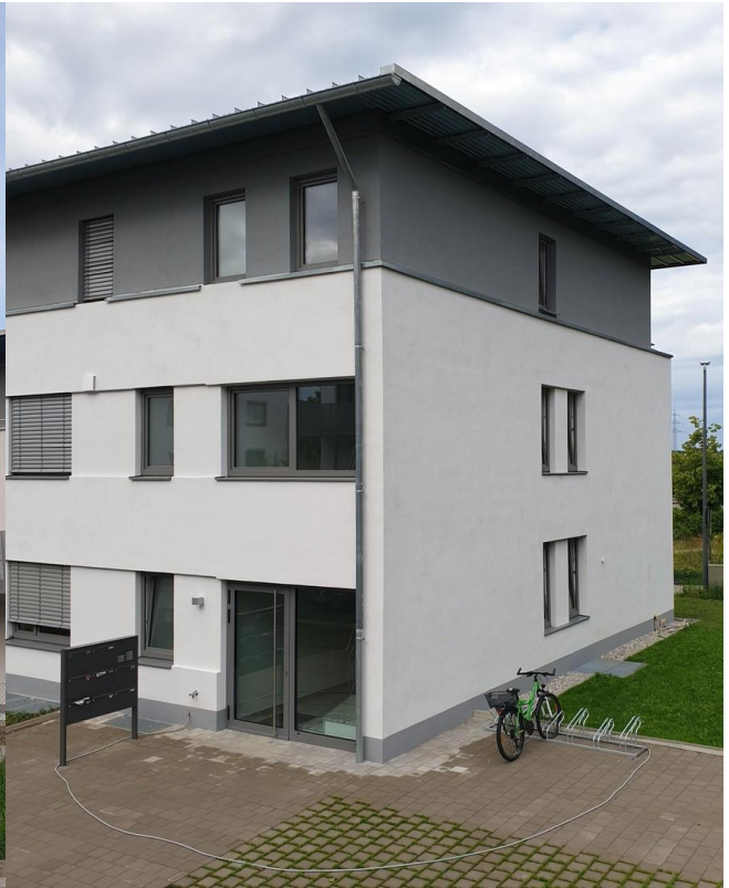
Außenansicht Osten, Eingang
