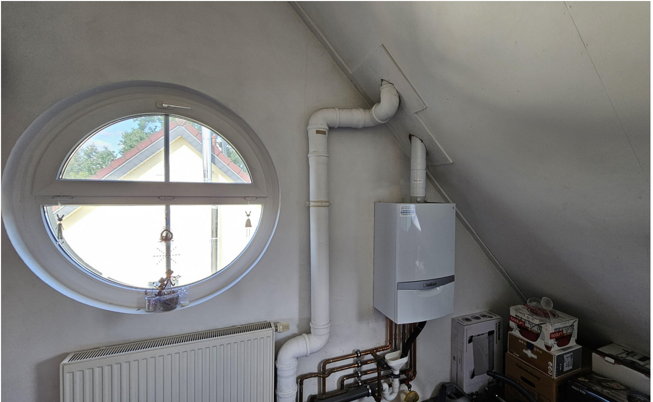
Fensterdetail i9m Dachgeschoss
