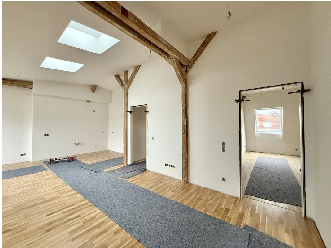
aufgearbeitetes Ständerwerk
