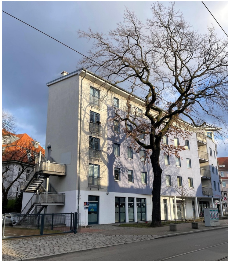
Straßenansicht EG links
