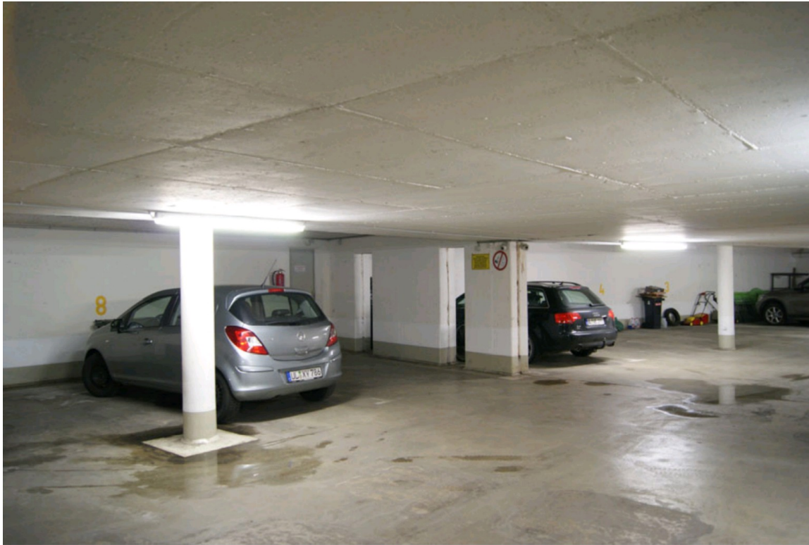
Tiefgragenstellplatz im Nachbargebäude
