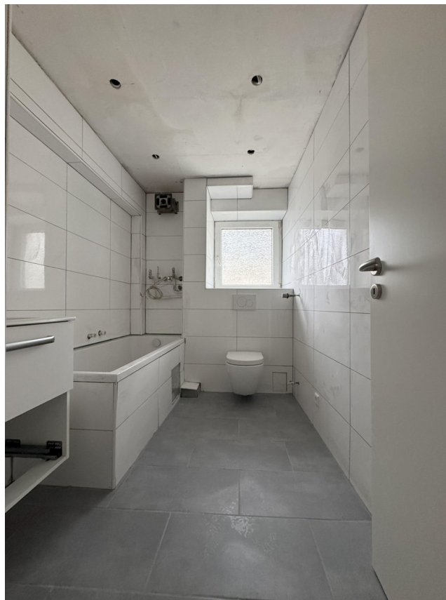
Bad (noch nicht fertiggestellt)
