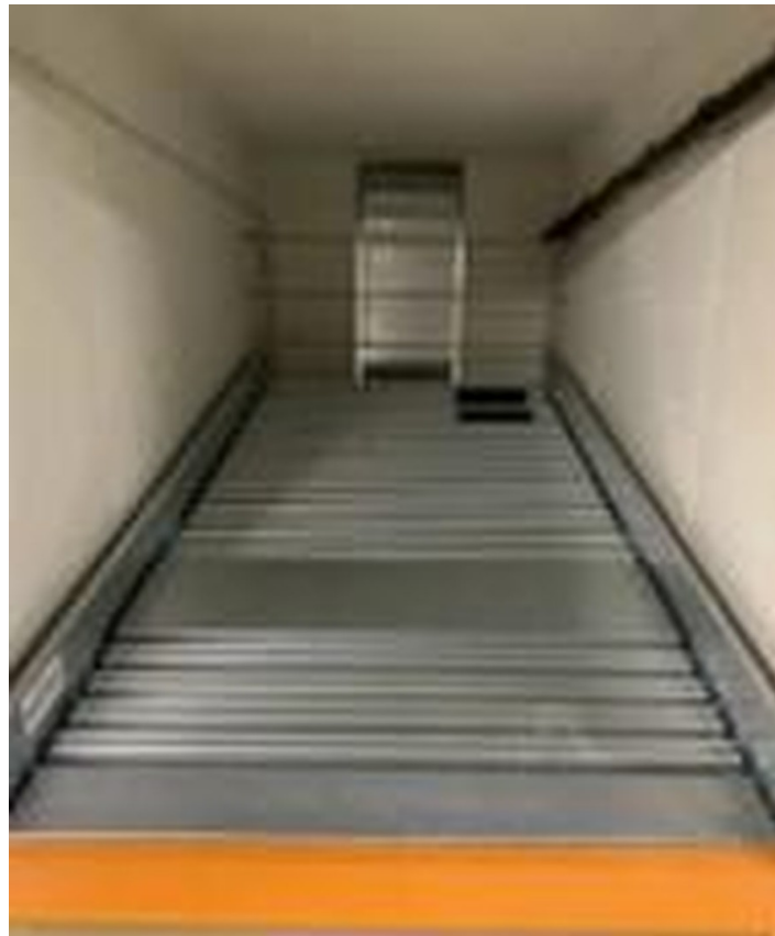
Duplex mit neuem Blech
