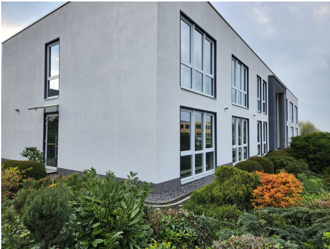
Seitenansicht des Gebäudes
