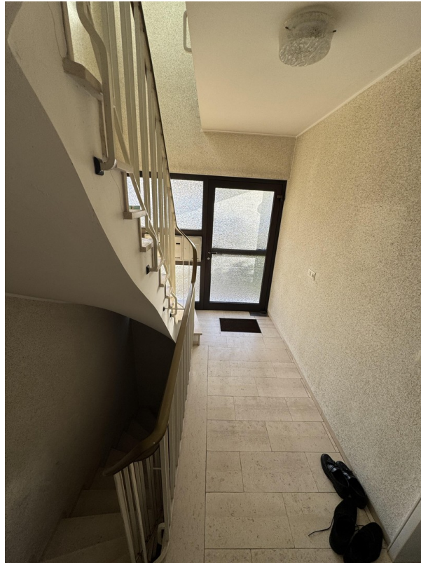
Haus 2 Treppenhaus EG
