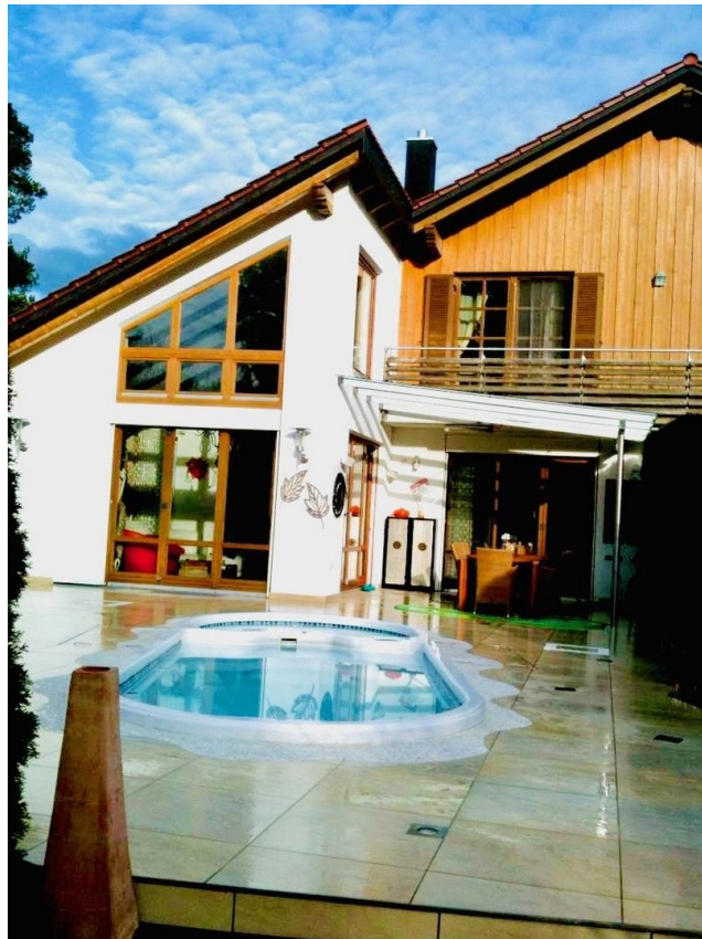
Westansicht mit Pool
