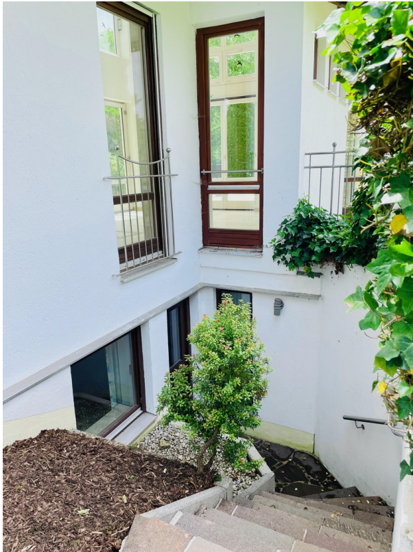
Abgang zum Einliegerbereich
