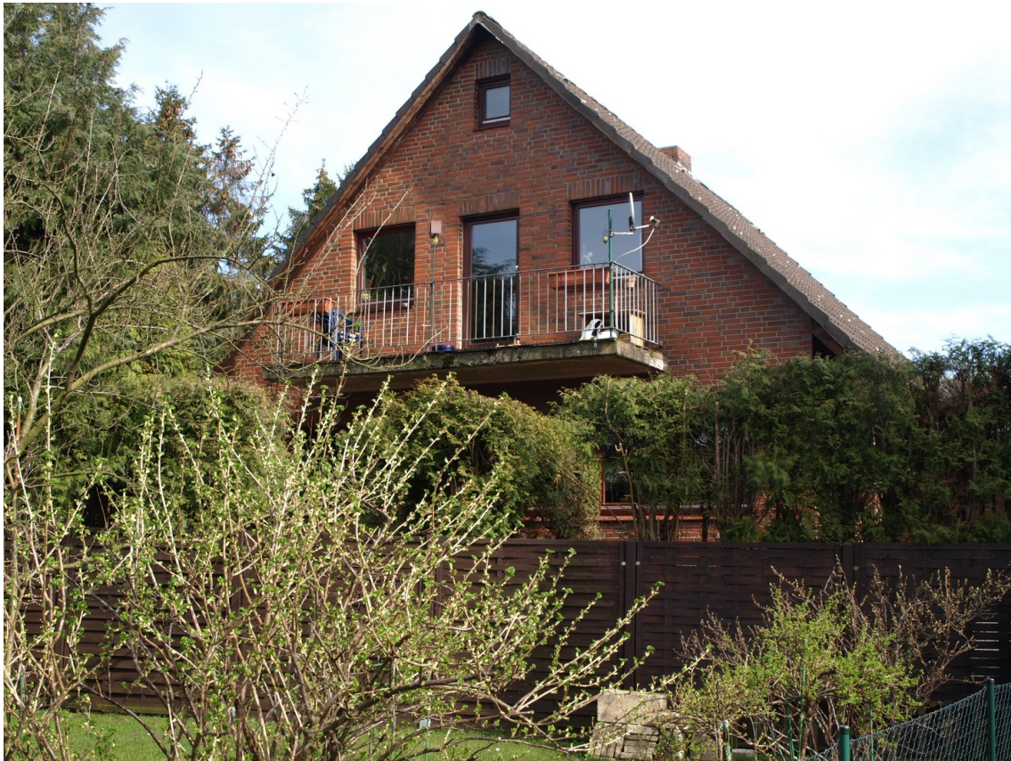
Giebelansicht SW Balk/Terrasse
