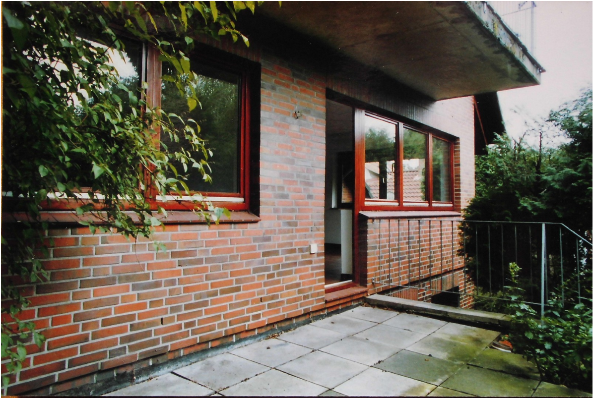
EG Gartenterrasse SW
