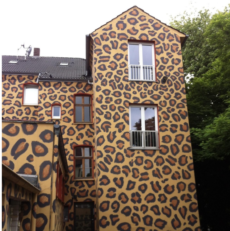
Eingang vom Hof
