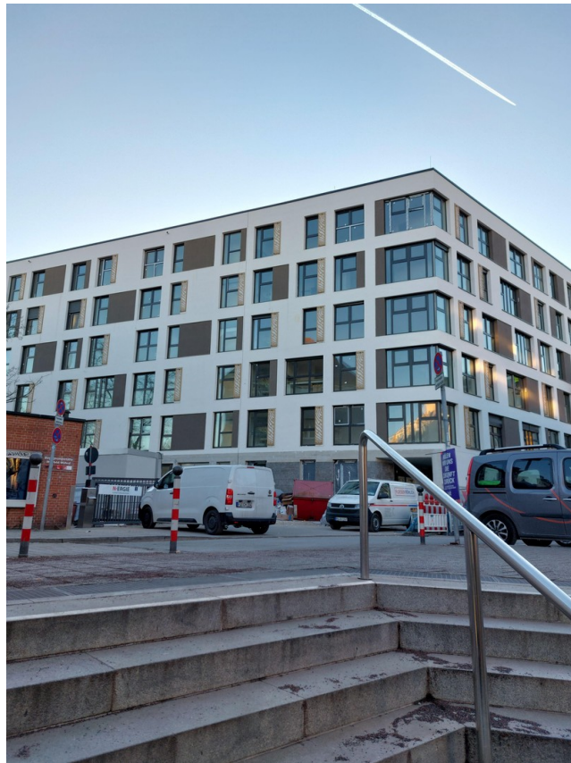
Blick Haus aus U-Bahn Aufgang
