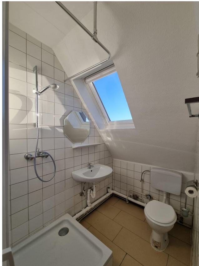
Duschbad mit Fenster
