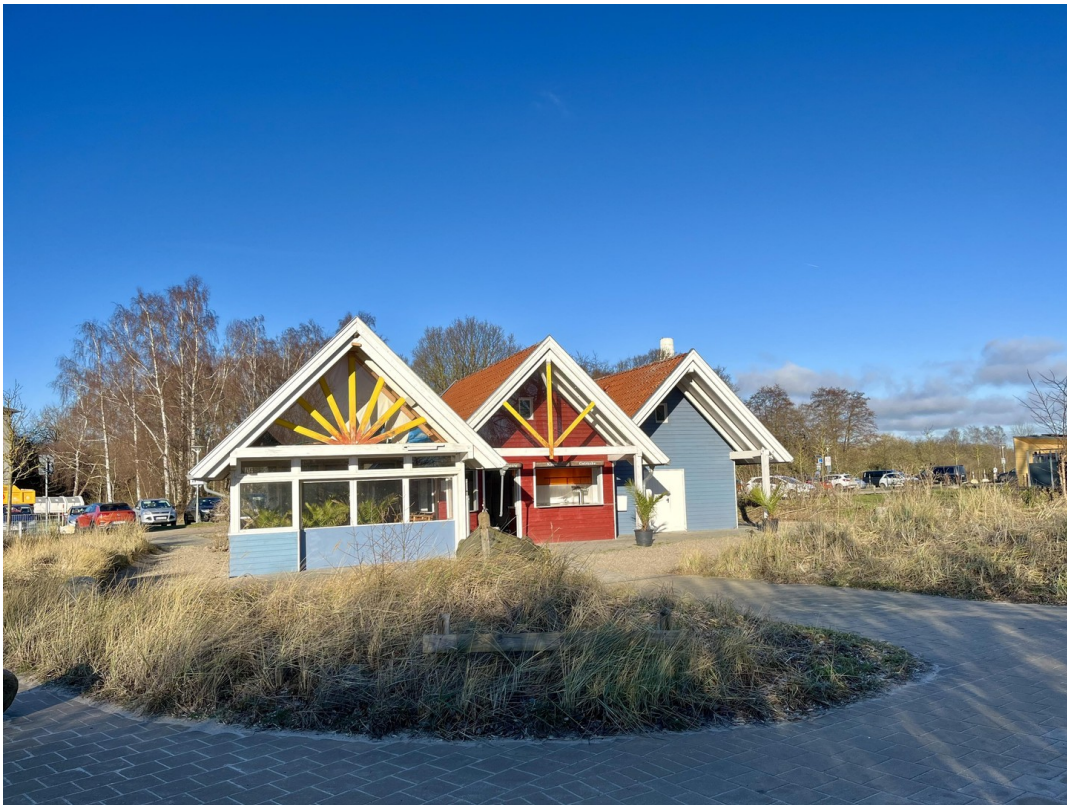
Blick von Strandweg
