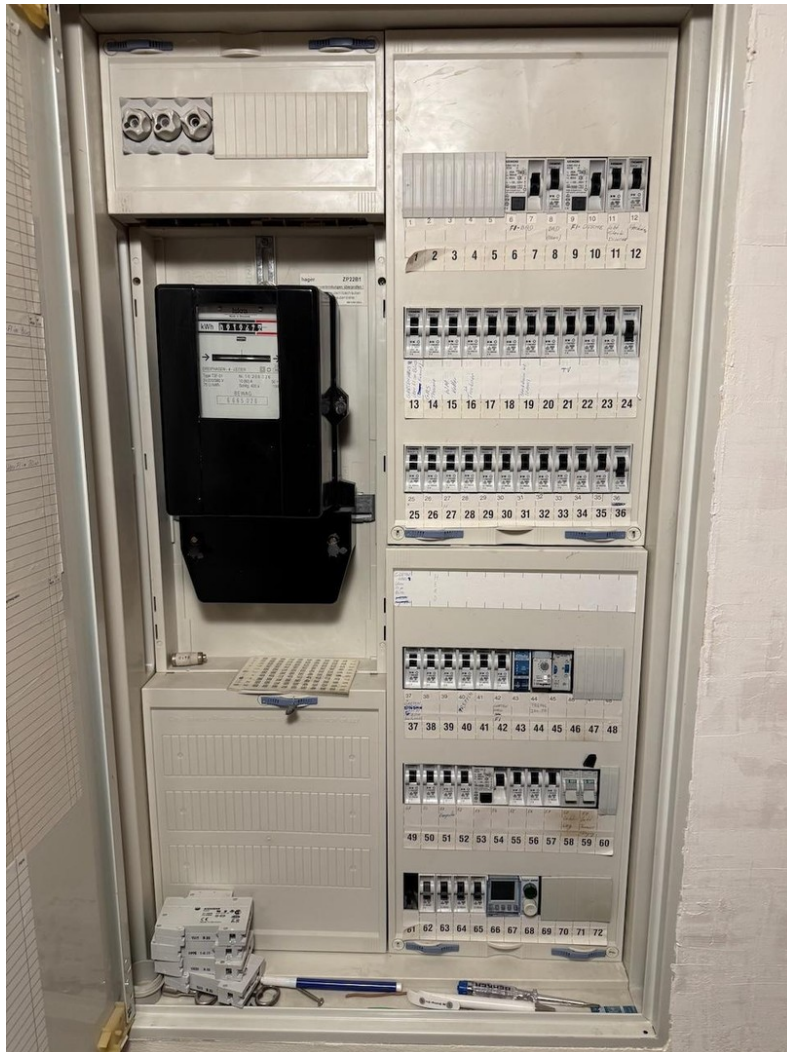
Verteilerkasten
