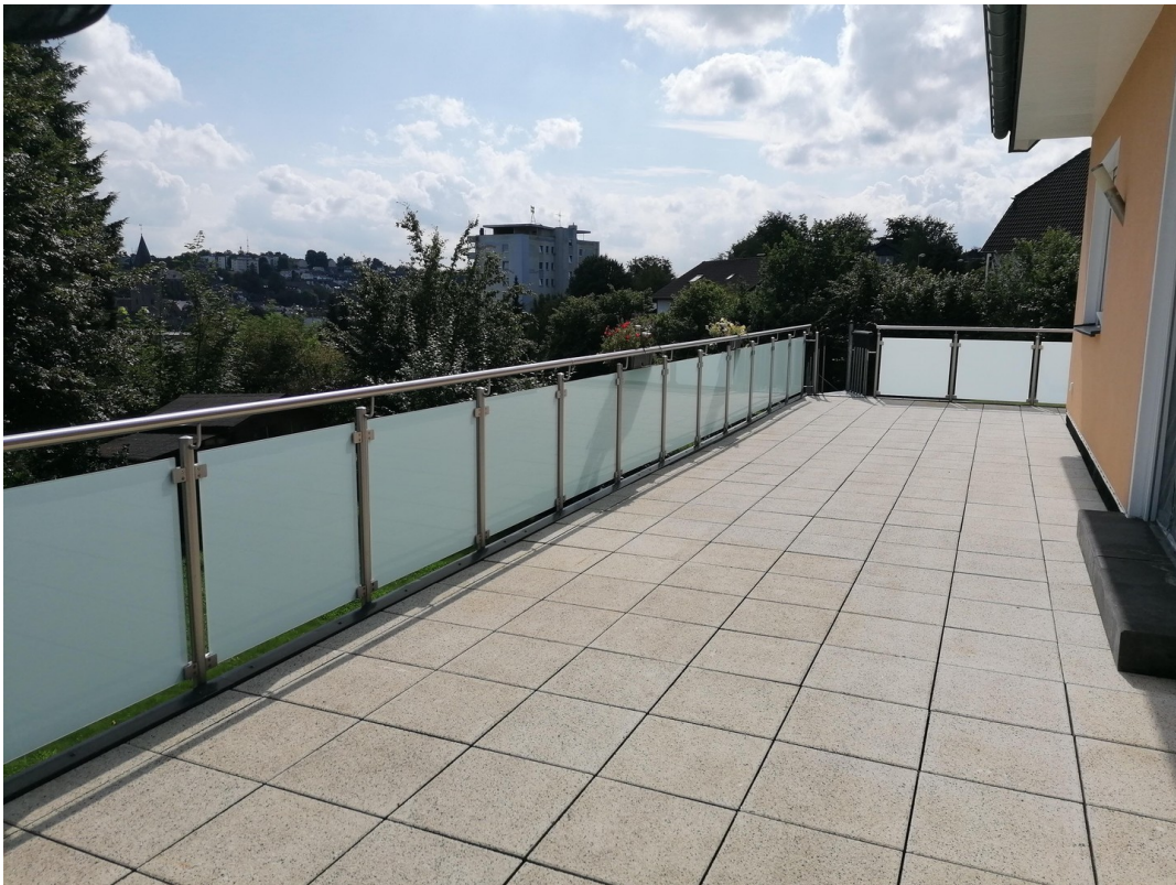
Balkon Südwest Ansicht
