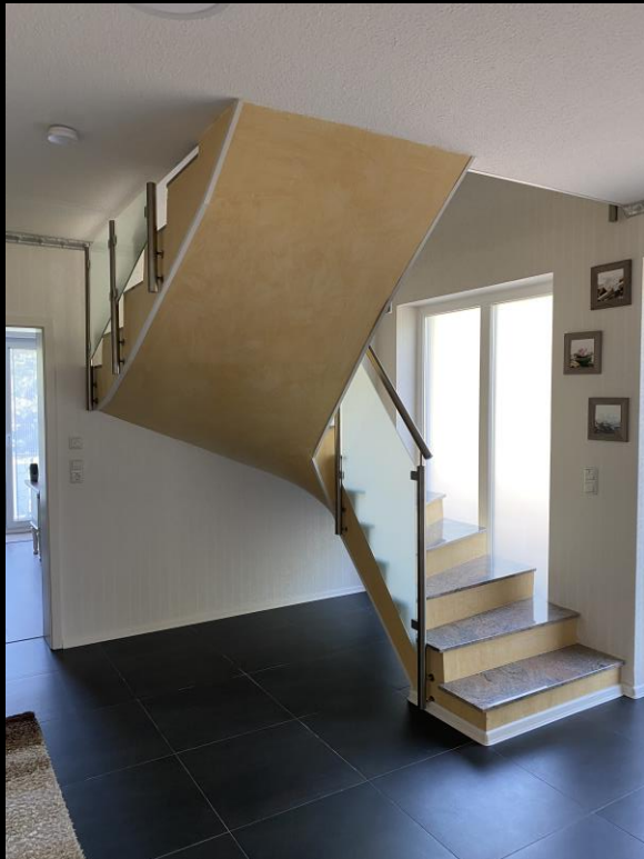
Innentreppe EG zu OG Massiv Beton
