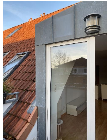
Balkontür von außen
