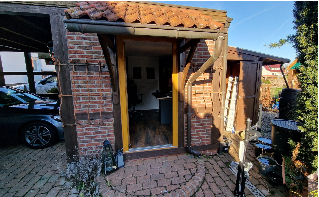
Nebengebäude Eingang im Garten
