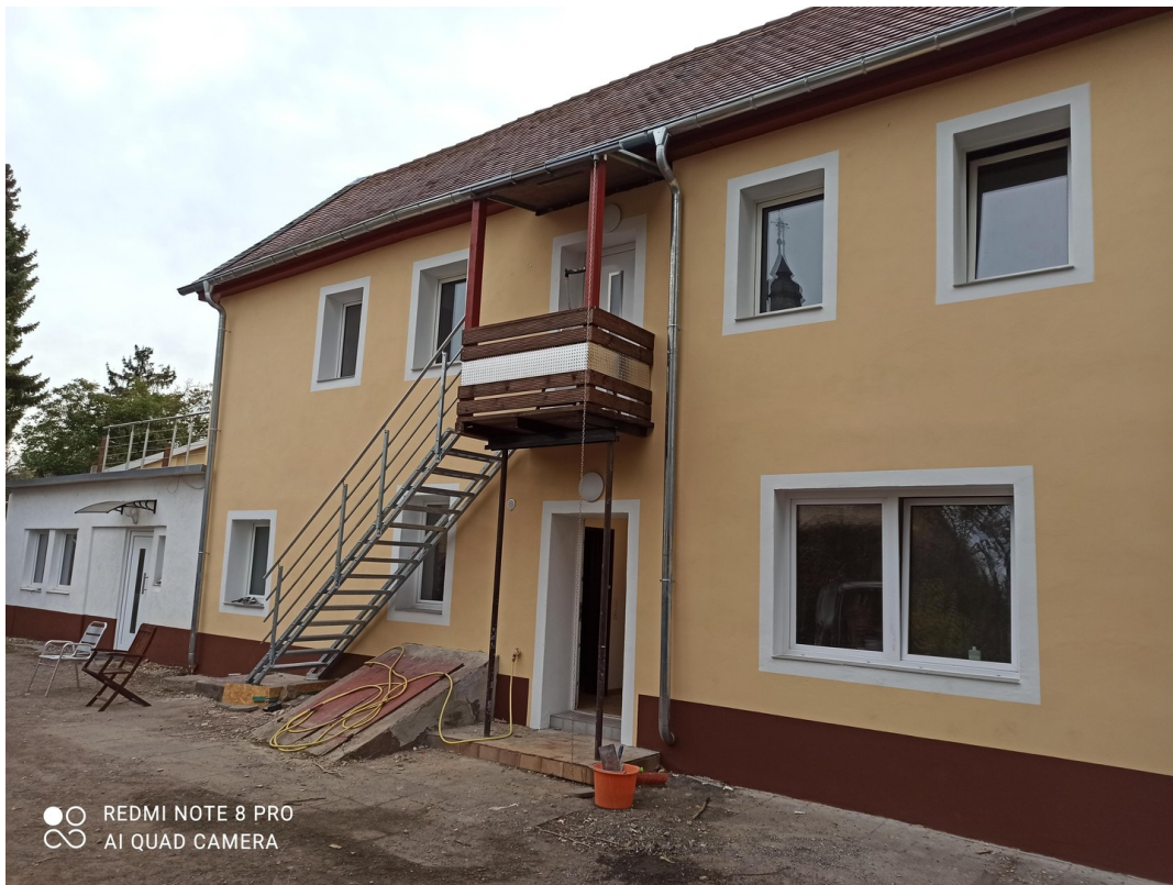
Anbau von großem Hof aus
