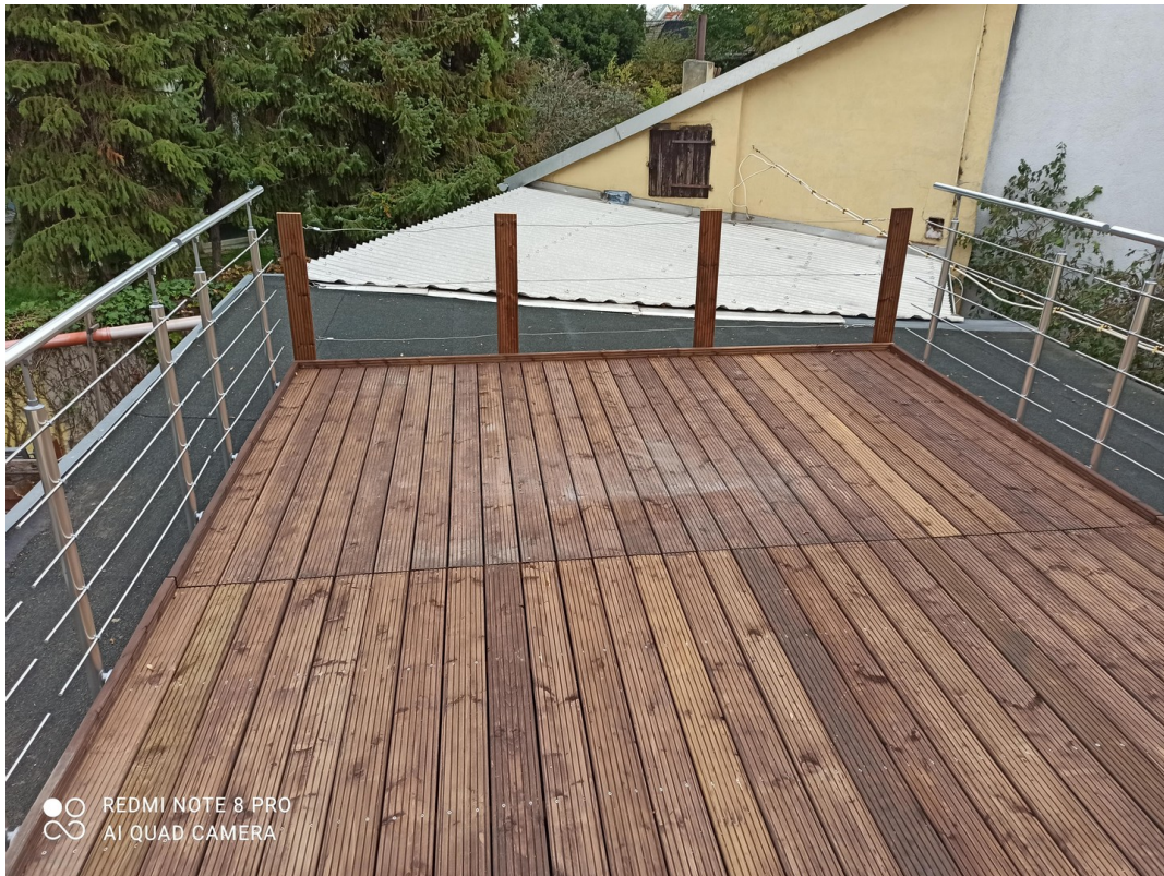
Dachterrasse am Anbau
