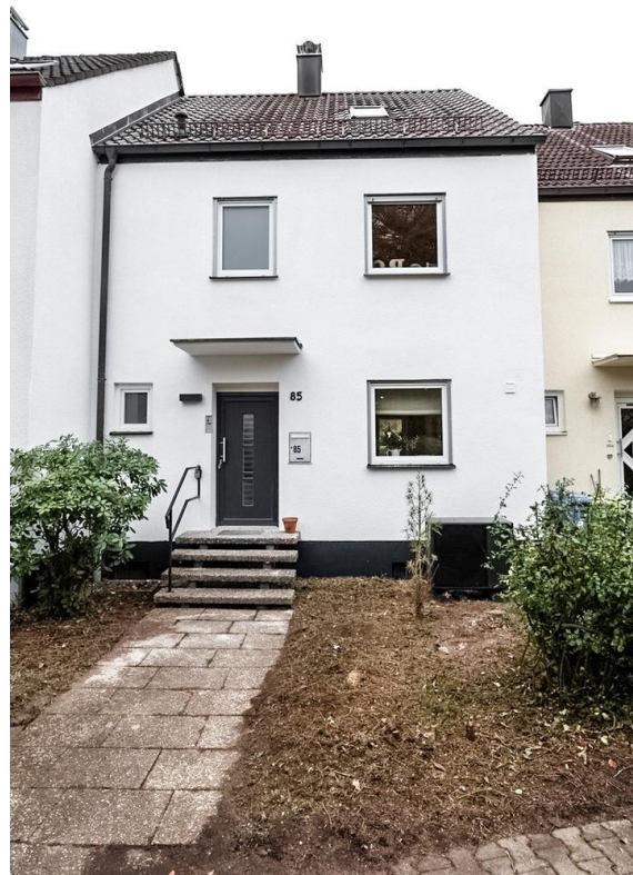
Außenansicht mit Wärmepumpe
