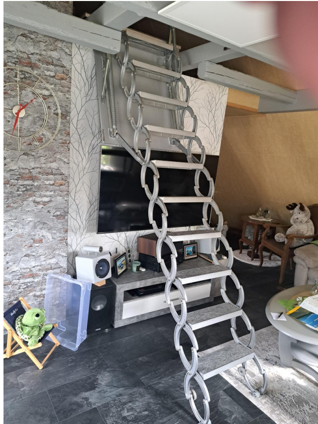
Scherentreppe zum Giebelraum
