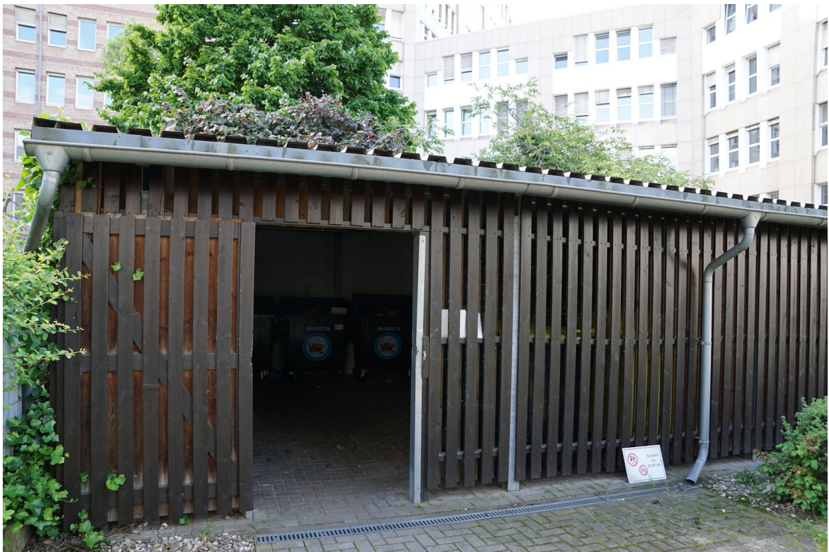
Mülltonnenraum an Hofzufahrt
