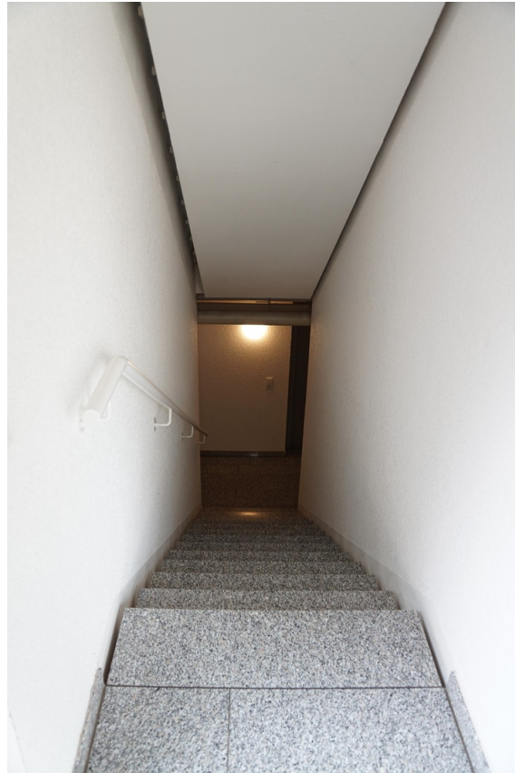
Treppenabgang in UG1 und UG2
