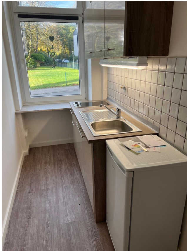
neue Küche mit Küchenzeile
