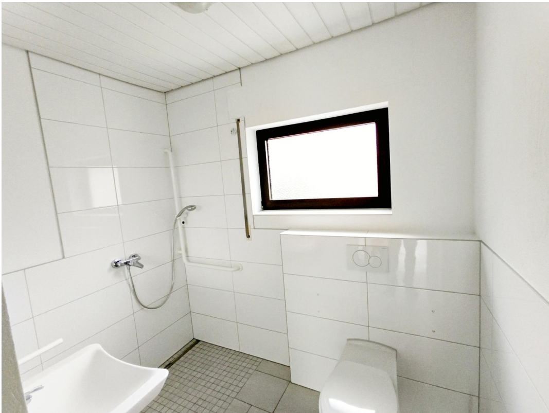
Bad mit Dusche 1. UG
