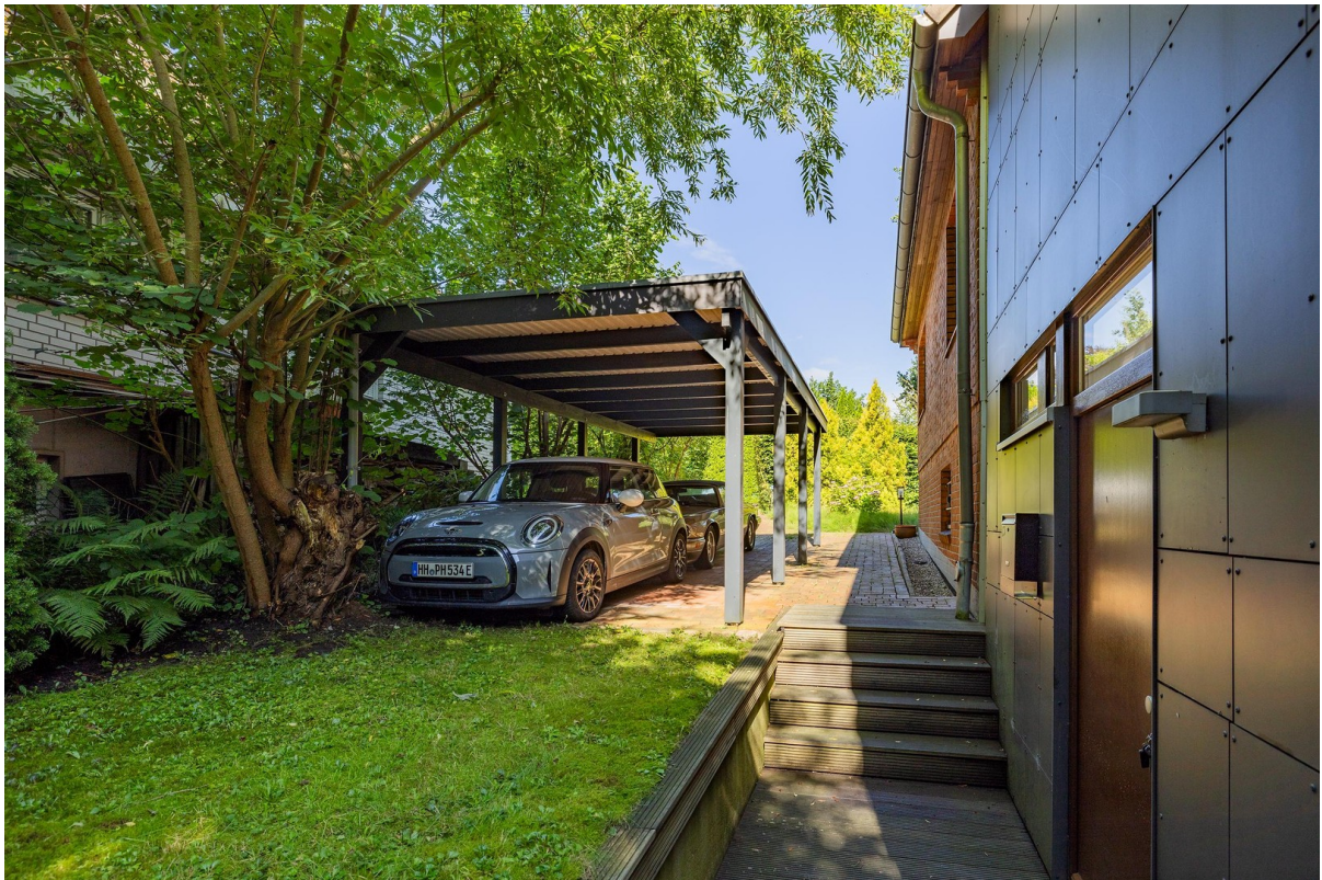
Doppelcarport, Eingang EG-Einh
