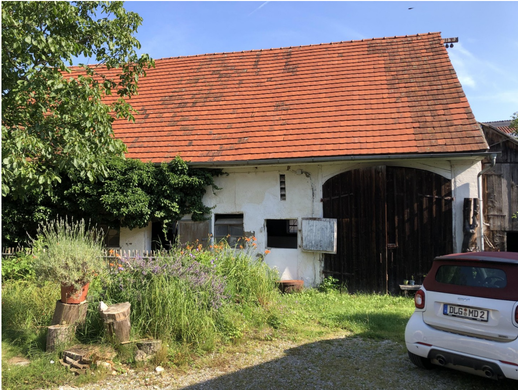
Ansicht Pferdestall m. Scheune
