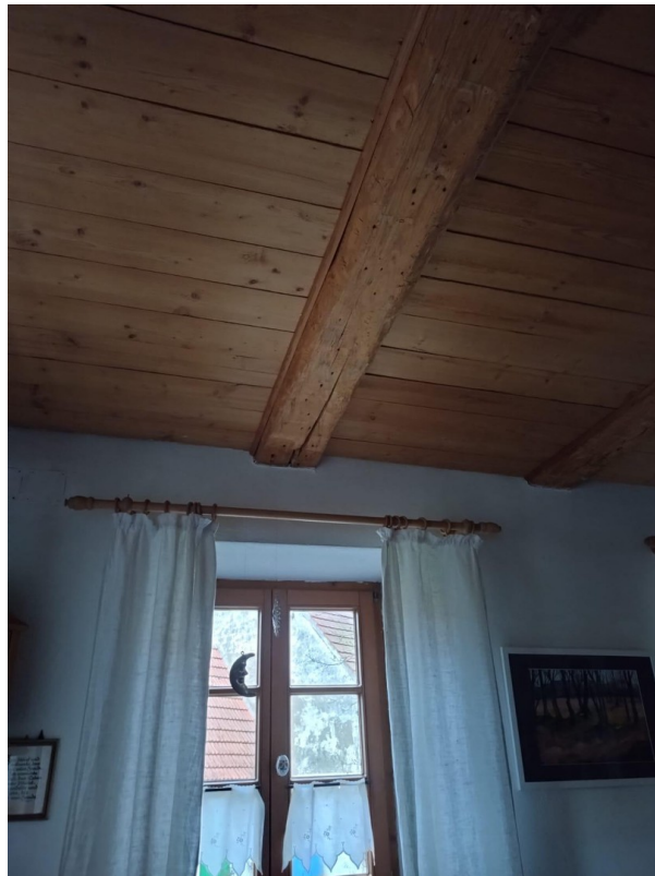
Balkendecke in der Küche
