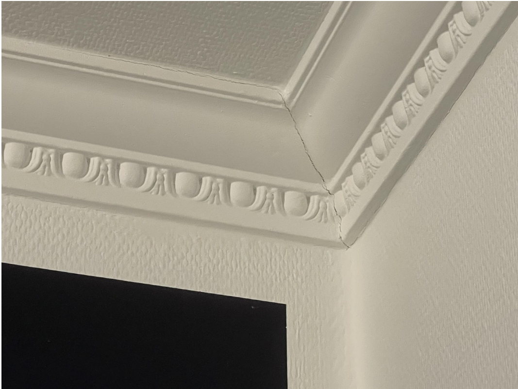
Altbau mit Deckenstuck
