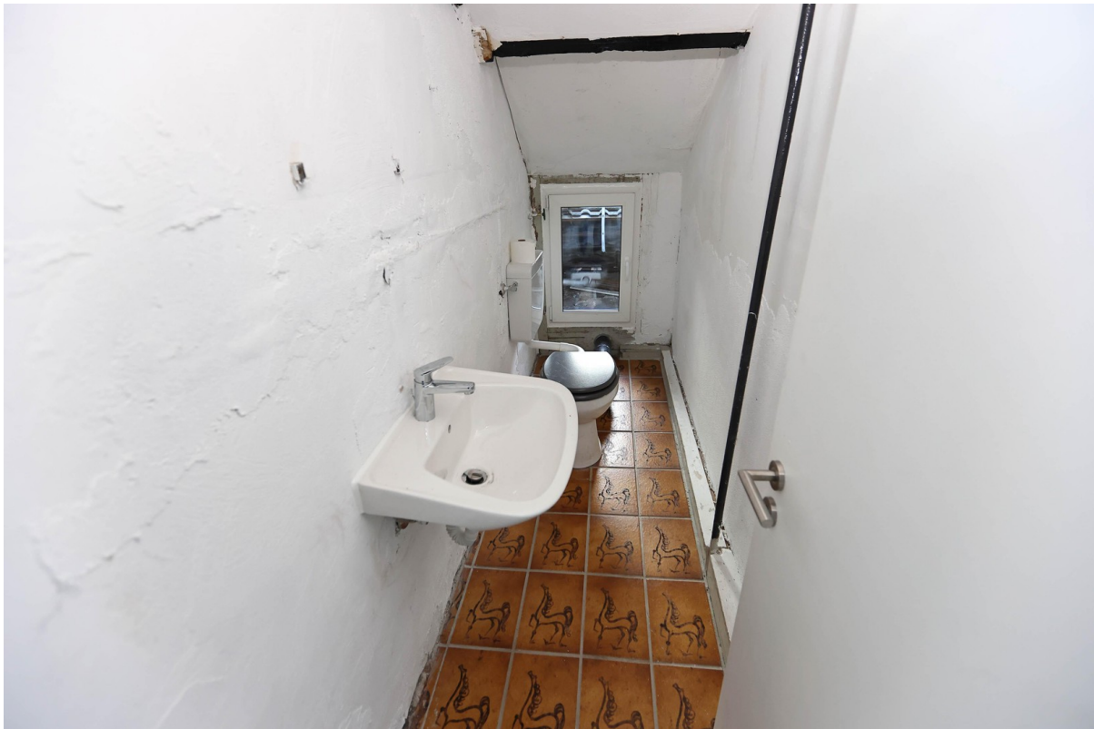
Badezimmer mit neuem Fenster
