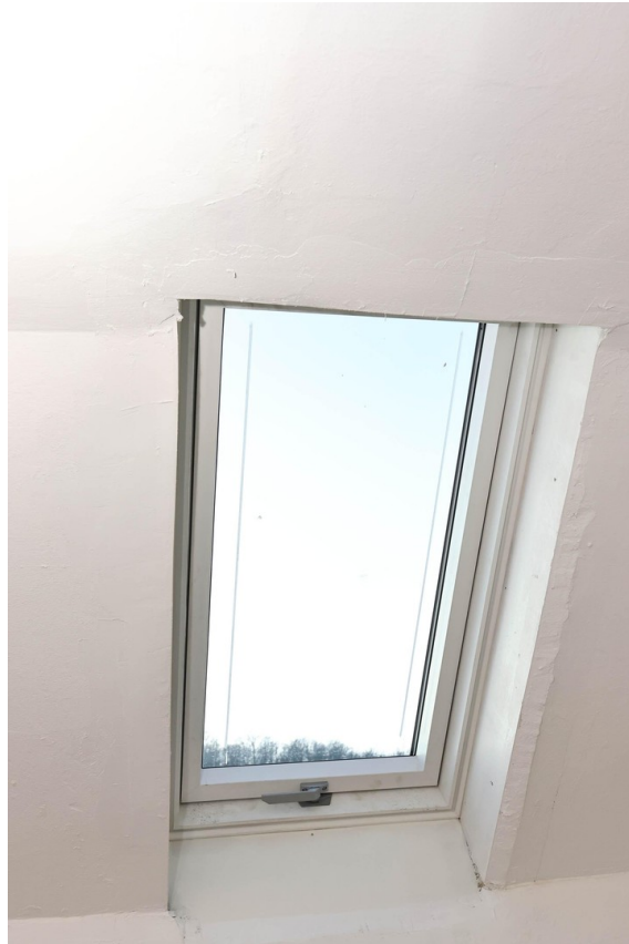
Neue Fenster in jedem Zimmer
