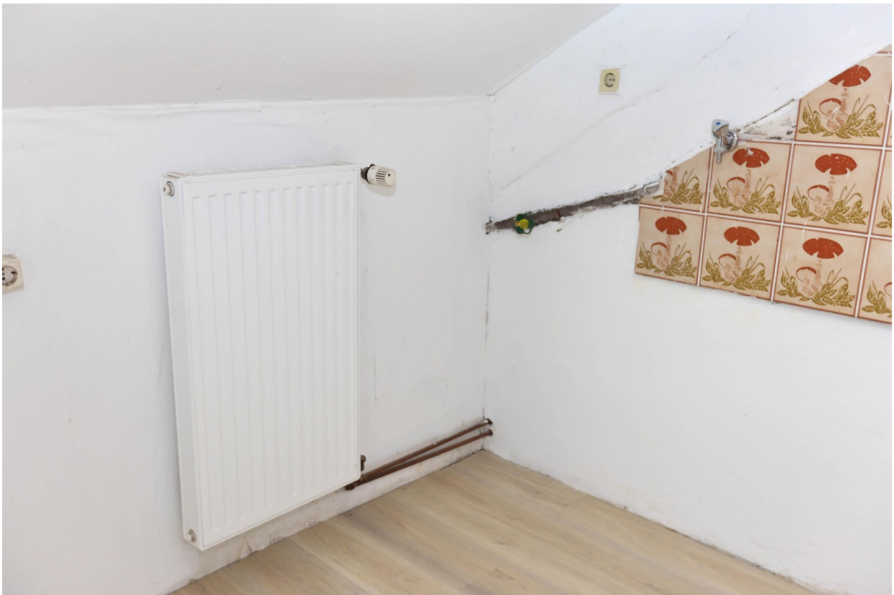
Neuer Heizkörper Küche
