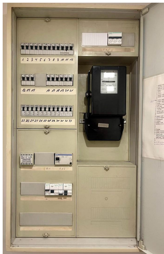
Elektro-Sicherungskasten
