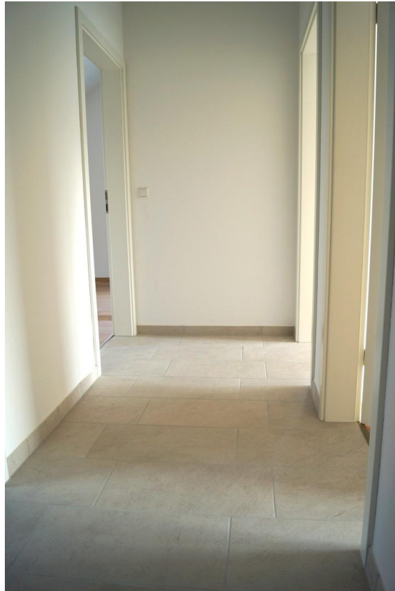
Flur im DG
