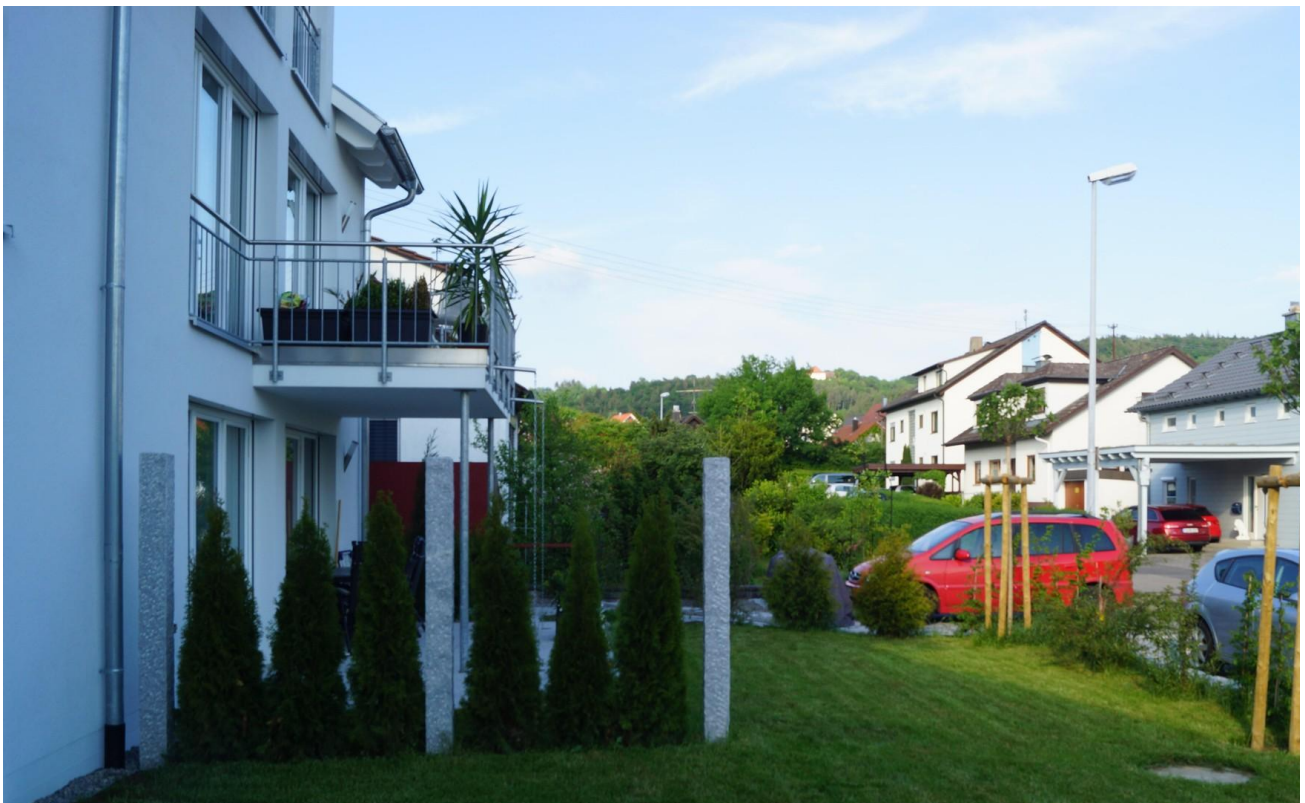
Aussen seitlich mit Balkon
