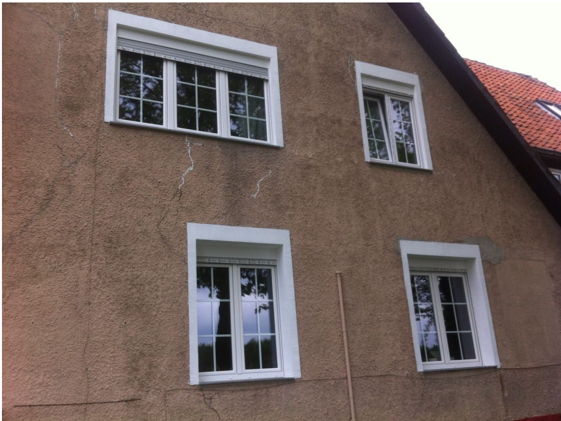
Fenster erneuert mit Rollläden
