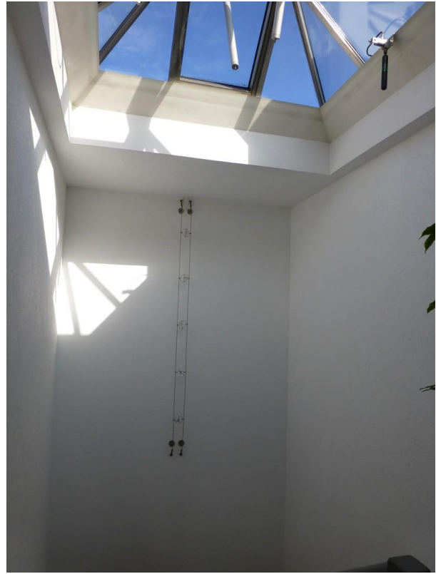
Lichtkuppel im Treppenhaus
