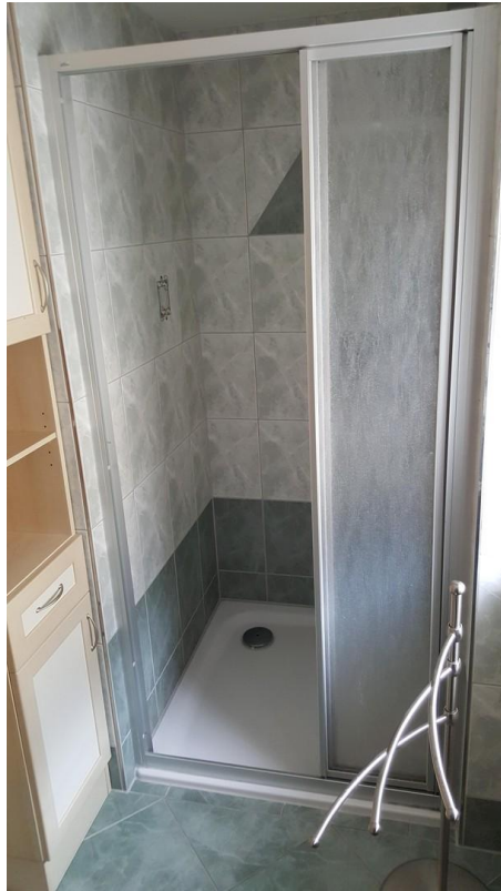
Dusche Detail Erdgeschoss
