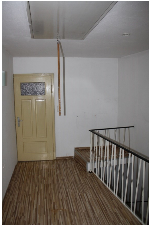
Flur OG2 Zugang Abstell- und HW-Raum
