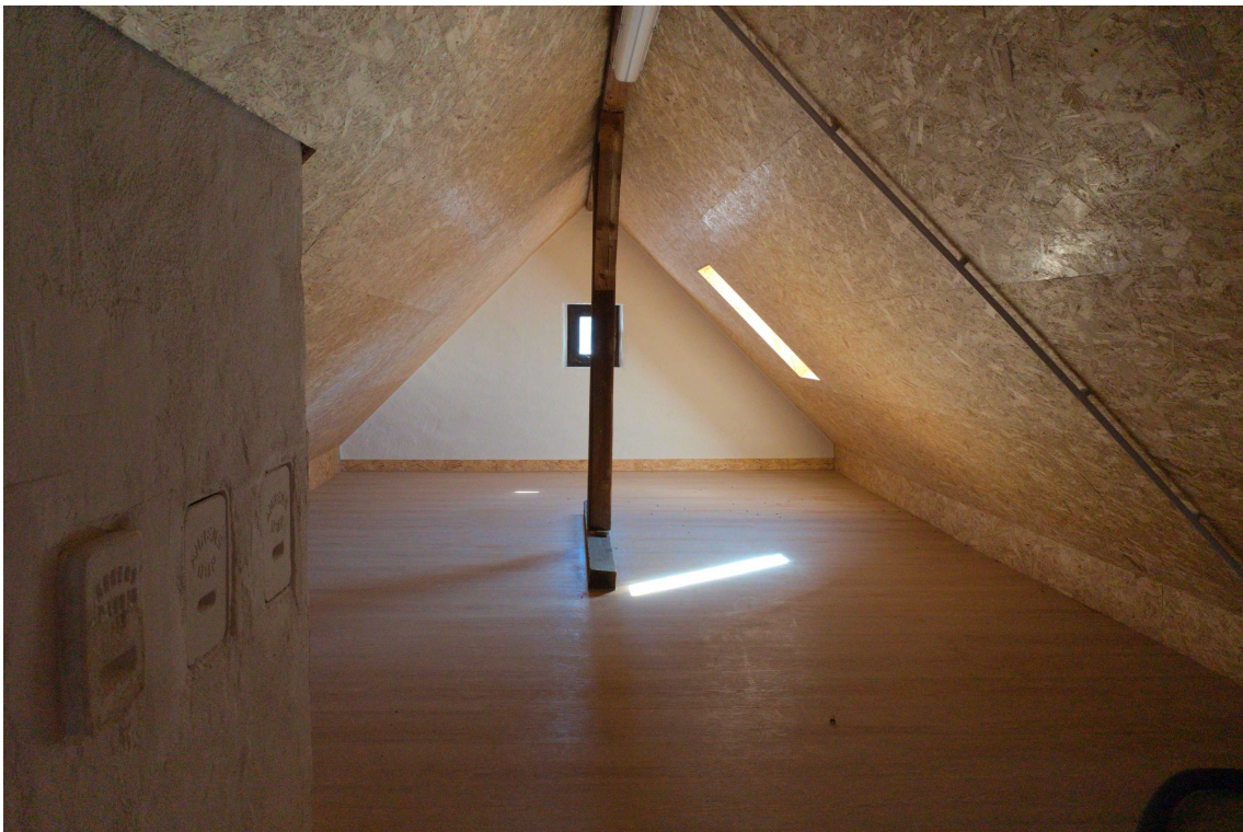
Ausgebauter und gedämmter Spitzboden
