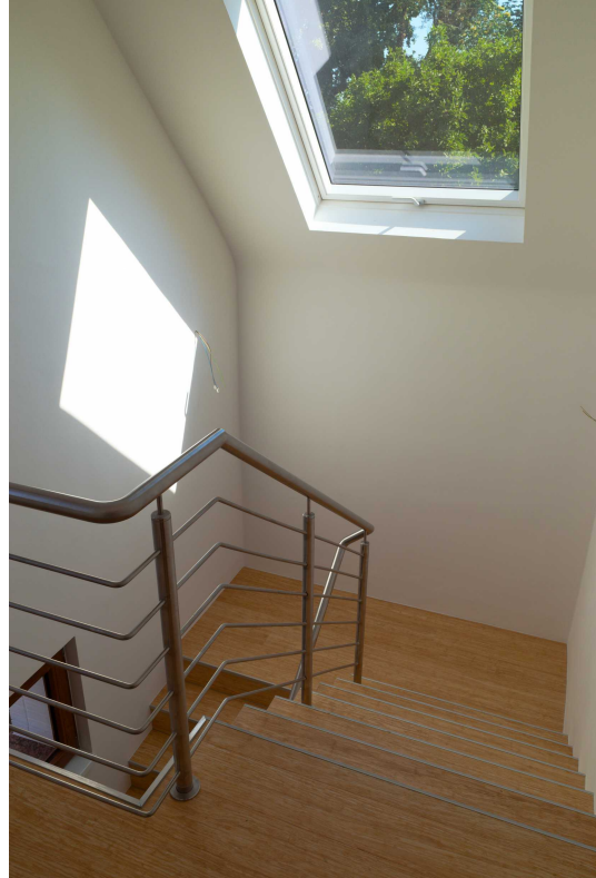
Treppe mit neuem Dachflächenfenster
