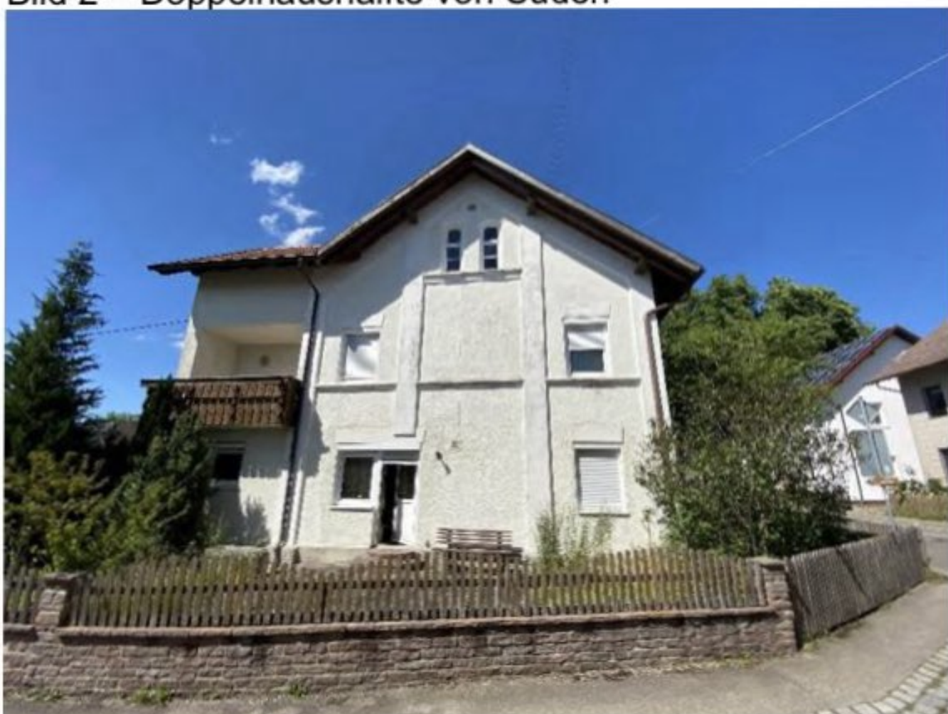
Bild 2 – Doppelhaushälfte von Süden
