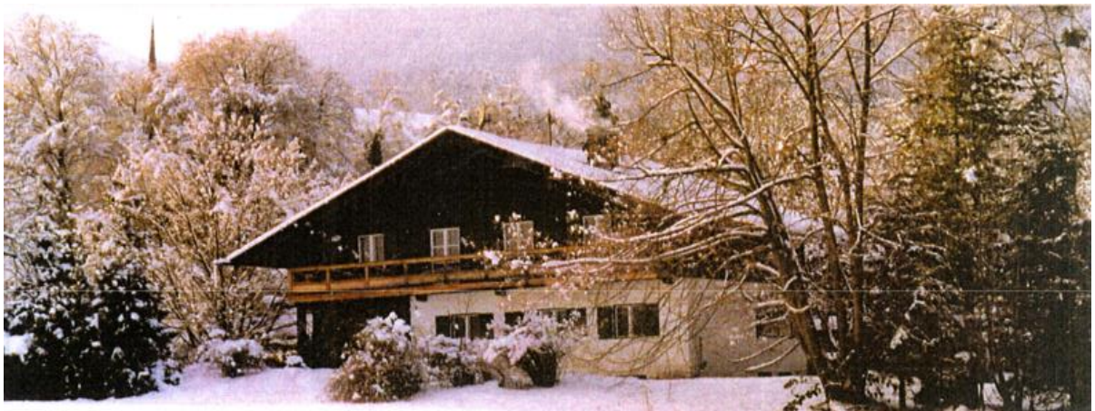
Abbildung 5 Wiesenweg12 im Winter Ansicht von Süden
