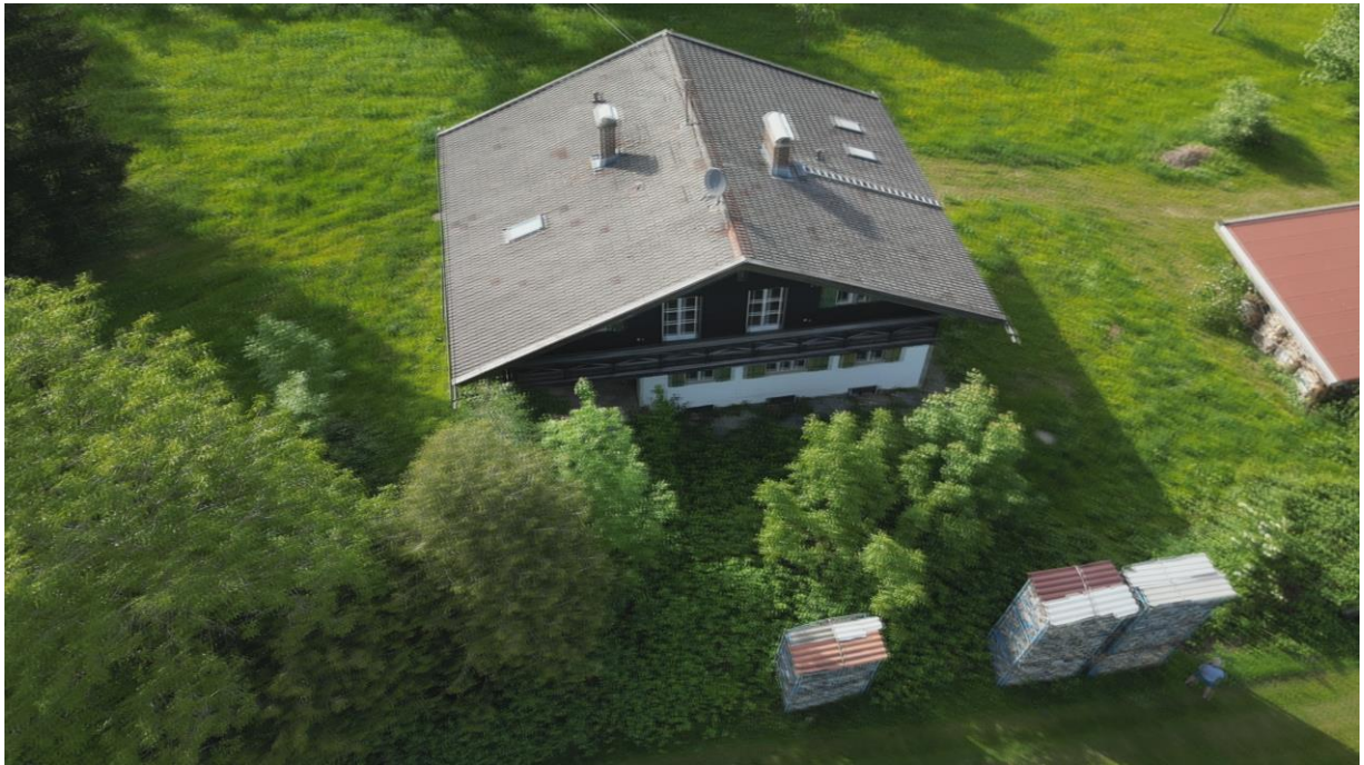
Abbildung 4 Wiesenweg12 Ansicht von Süden
