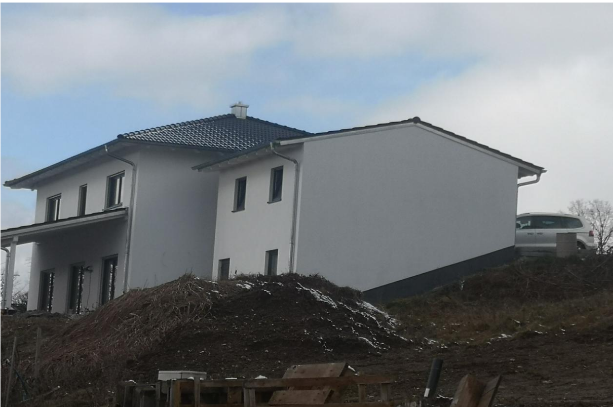
Rechte Nachbarbebauung / die Aussenanlagen werden aktuell begonnen
