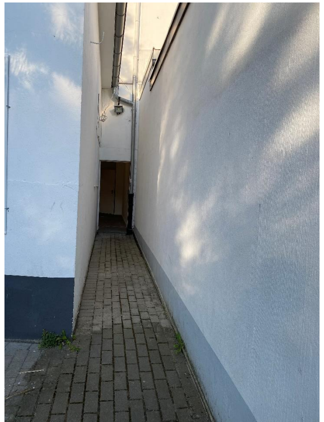
12. Abbildung: Hintereingang vom Parkplatz
