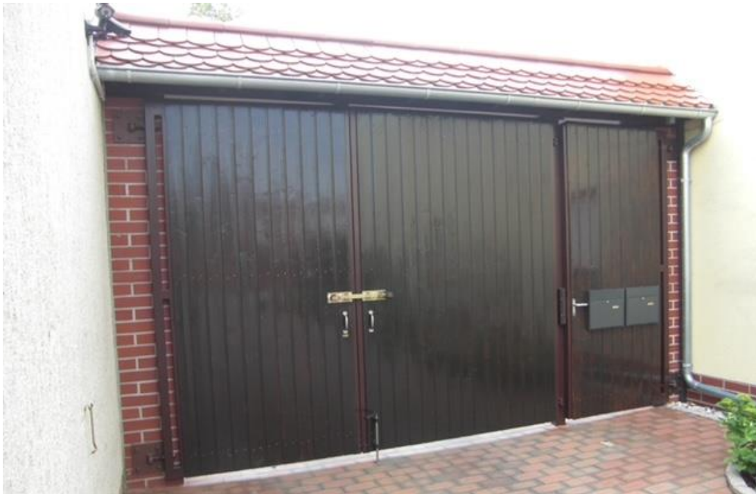
Hofter (Blick vom Innenhof): Über die gemeinsam genutzte Überfahrt gelangt man in den Innenhof
