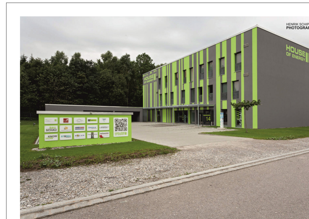
Bürogebäude mit Betriebsleiterwohnung im Passivhaus Premium Standard mit 40,5 kWp Photovoltaikanlage und Ladesäule
