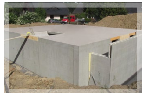
Der fertige Keller.
