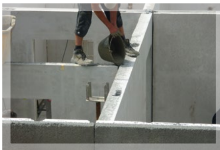
Die senkrechten Stoßfugen werden vergossen.
