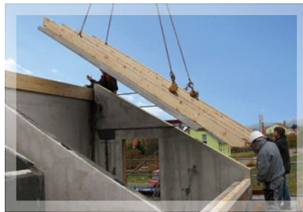
Auflegen der Massivdachelemente
