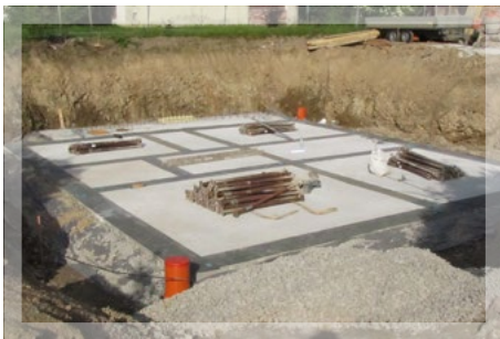
Die Bodenplatte ist zur Aufnahme der Fertigteilwände vorbereitet.
