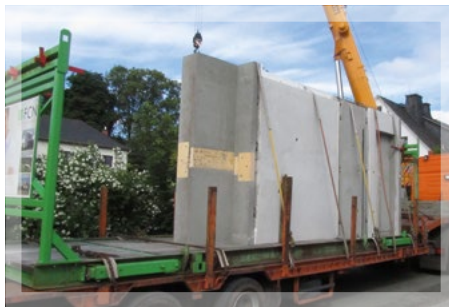
Anlieferung der FCN-Massivwände.
