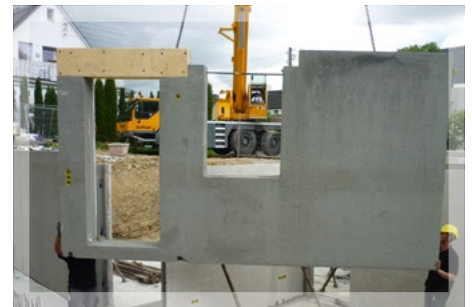
Die FCN-Massivwände werden mit Autokränen auf die Bodenplatte versetzt und fixiert.
