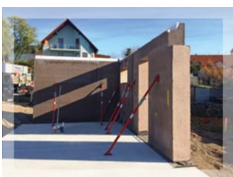
Montage Erdgeschoss
