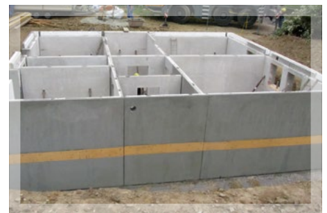
Die Kellerwände sind montiert.
