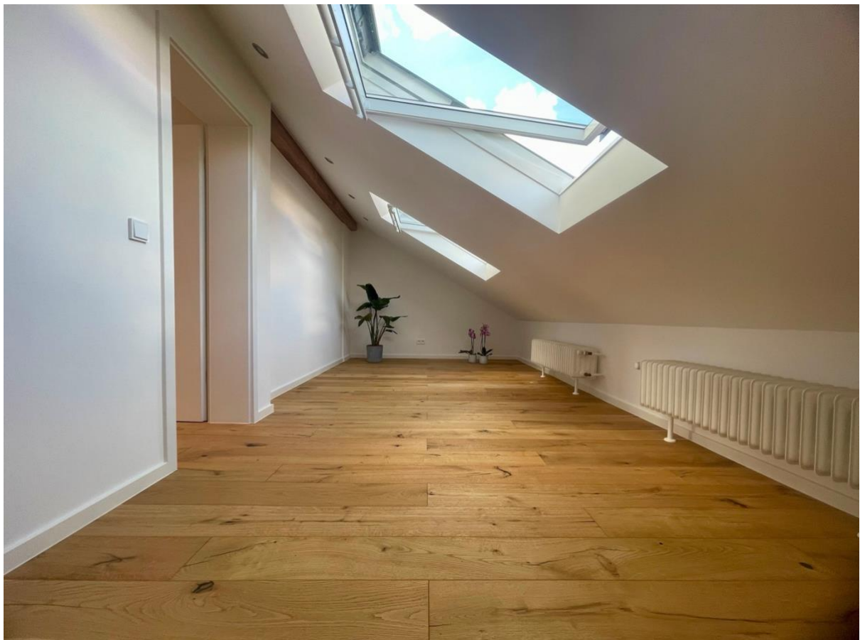
Helle Räume dank der elektrischen und großen Velux-Dachflächenfenster, welche per App über den eingebauten „Velux KIX 300“ steuerbar sind
