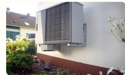
Luftwärmepumpe
